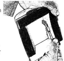
Ausschnitte für Rohr und Spindel sind stets „knapp“ auszuführen und Hohlräume zwischen Dämmplatte und Armaturenkörper so klein wie möglich zu halten.
